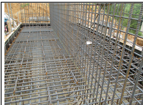
A2 기초 시공 전경
