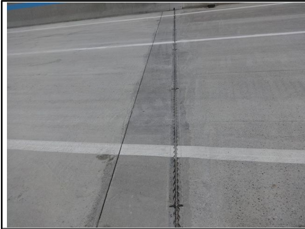
신축이음 A1 전경
