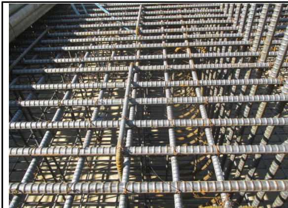
P7 기초 철근 조립 상태 2014.08.13
