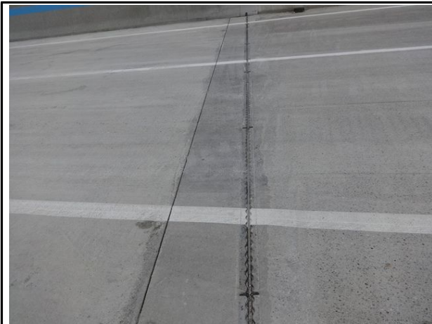
신축이음 A1 전경
