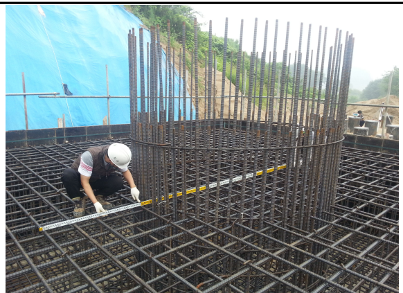
P7 기초 철근 조립 상태 2014.08.13
