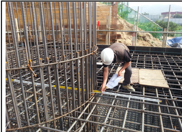
P6 기초 철근 배근 간격 측정 2014.07.21
