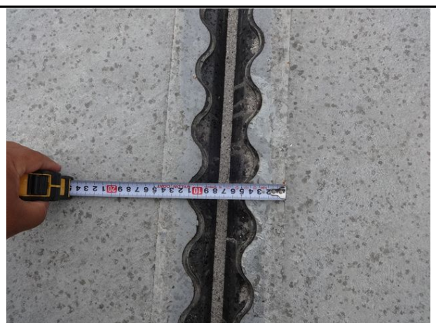
신축이음 P7 유간 측정
