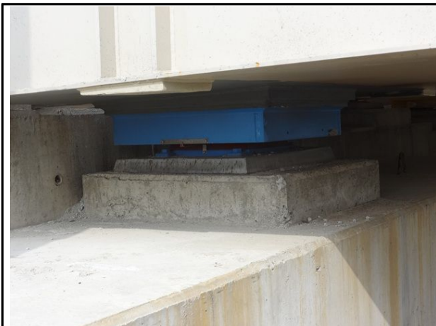
교량받침 P6-SH2 전경
