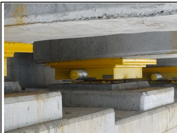
교량받침 A1-SH2 전경
