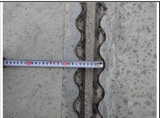
신축이음 A2 유간 측정
