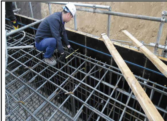
P8 기초 철근 조립 상태
