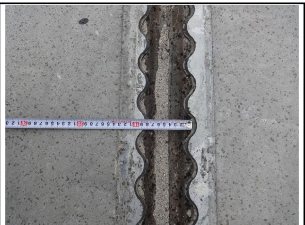
신축이음 P2 유간 측정
