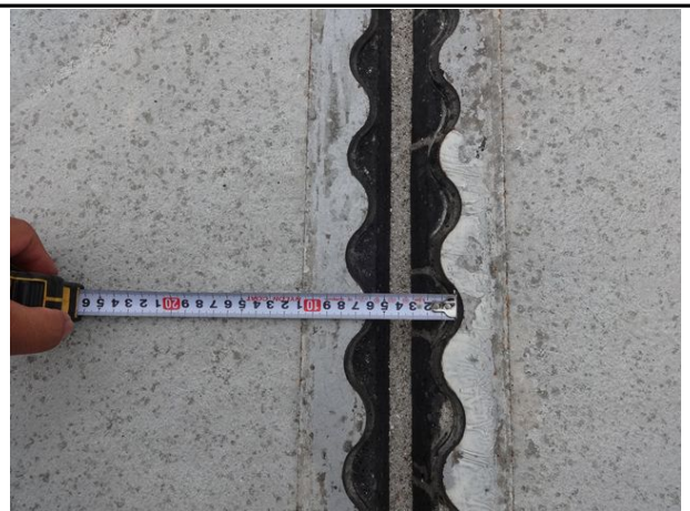
신축이음 P6 유간 측정
