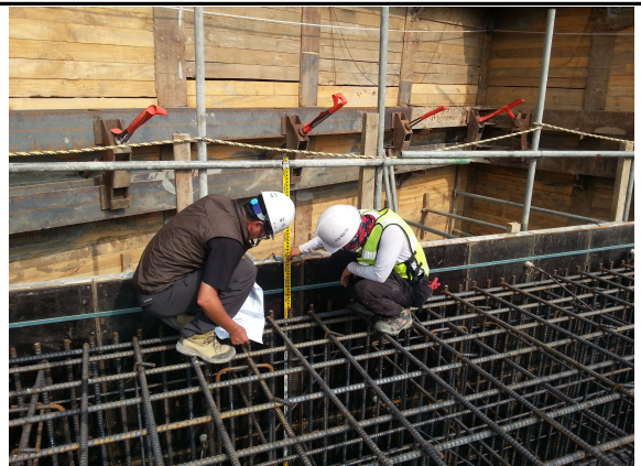
P6 기초 시공 상태 검측 2014.07.21
