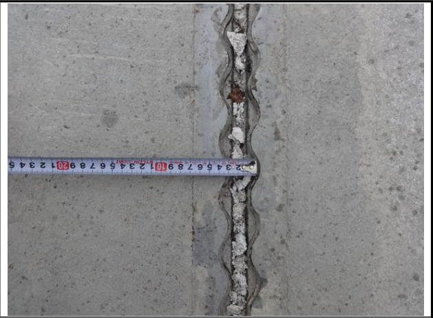
신축이음 A1 유간 측정
