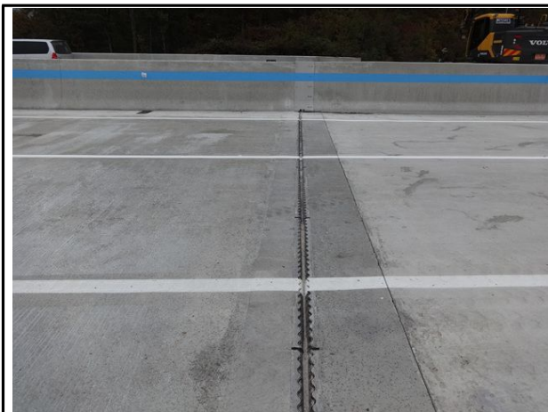
신축이음 A2 전경
