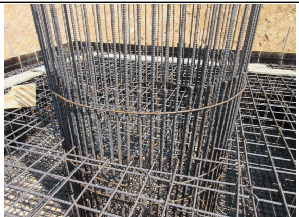
P9 기초 시공 상태
