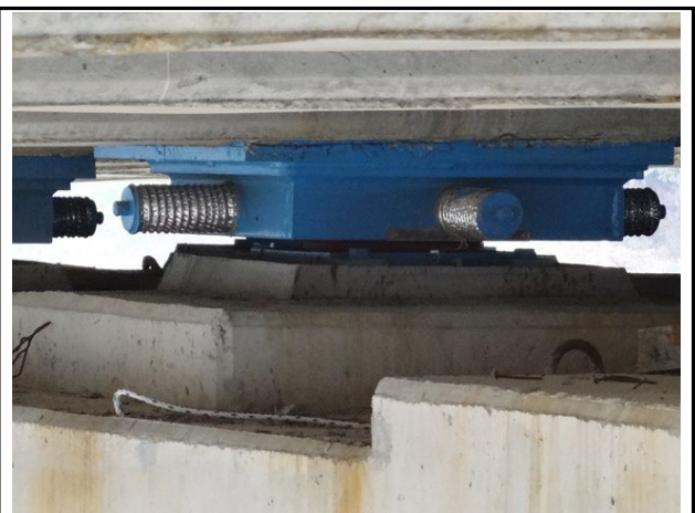
교량받침 P1-SH1 전경
