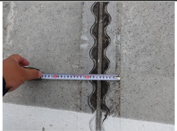
신축이음 P3 유간 측정
